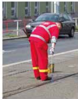
Bauarbeiter Tschechische Republik
